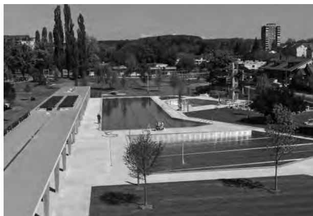
Die frisch sanierte und umgebaute «Badi Oberi» kurz vor dem Ansturm der zahlreichen, neugierigen Badegäste.
