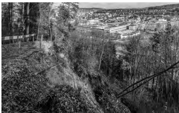
Hangrutsche wie hier am Kronenrain haben umfangreiche Sicherungsarbeiten ausgelöst.
