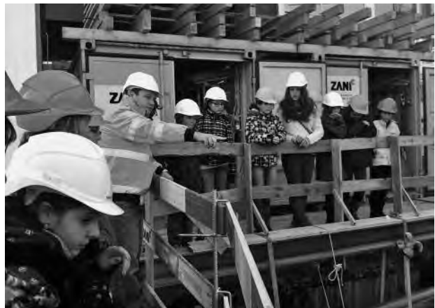
Die Besichtigung der Baustelle am Bahnhofplatz Süd erfreute sich am Zukunftstag grosser Beliebtheit.
