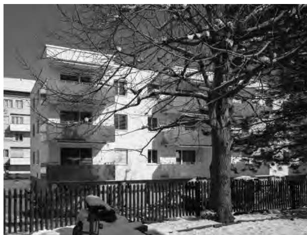
Die sanierte Liegenschaft Bürglistrasse 3+5.
