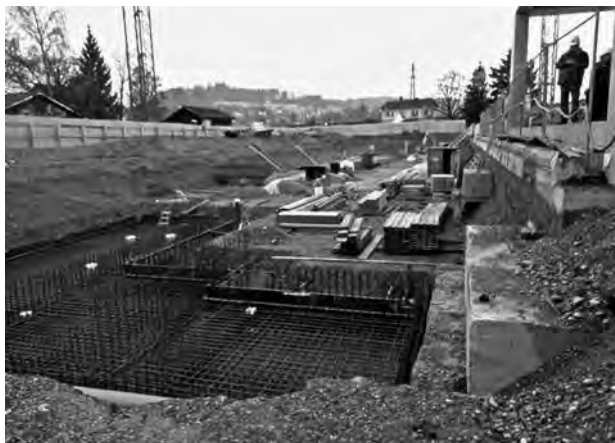
Baugrube Werkhof Scheidegg: Nach dem Spatenstich im Oktober wurde bis Ende Jahr die Baugrube erstellt und mit den Fundationsarbeiten begonnen; rechts das neu erstellte Waaghaus der KVA.
